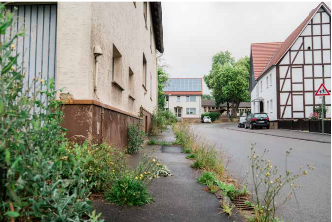
Zugewachsener Gehweg in der Bachstraße im Ortsteil Sielen
