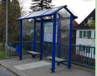
Bahnhof (Brücke) - C
